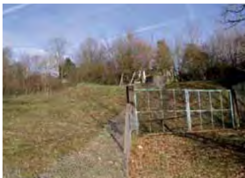
Station d'épuration de Monthoz
