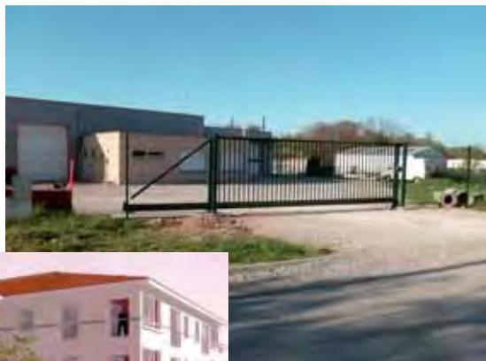
Clôture des ateliers municipaux
