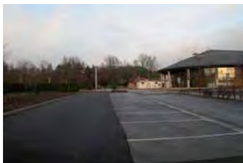
Extension du parking du centre Innovance
