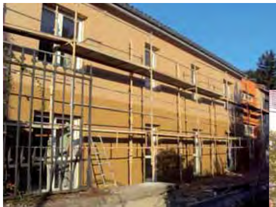
Travaux foyers logements
