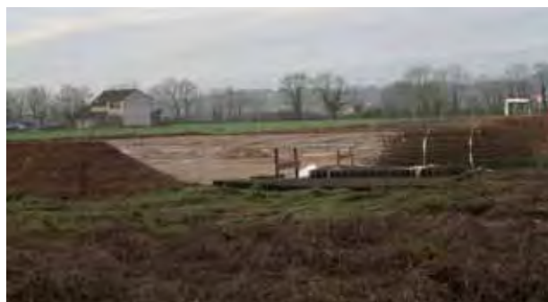
Début des travaux de la nouvelle salle des fêtes
