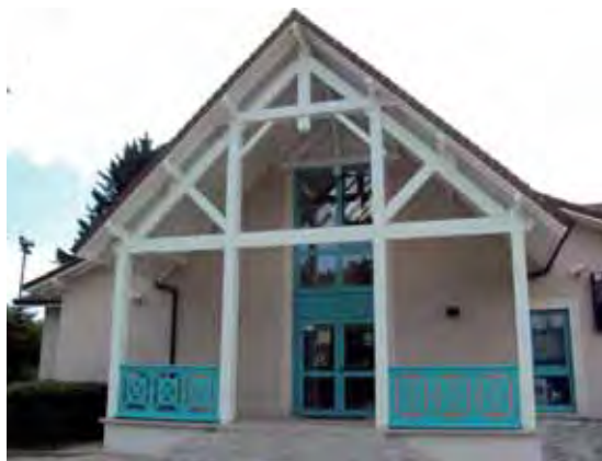
Nouvelle charpente du auvent de la MPTM
