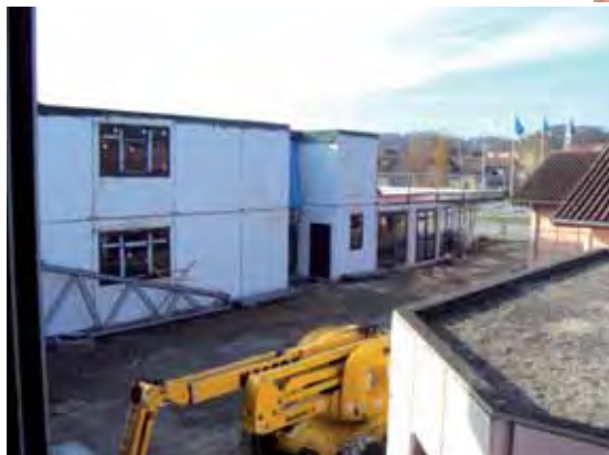
Construction de l'école maternelle
