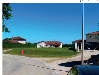
Logements à Monthoz
