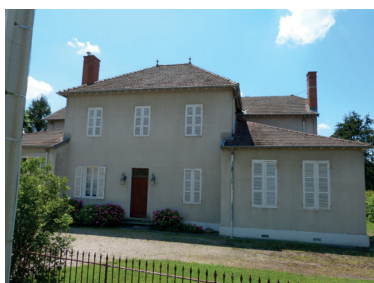
Grosse bâtisse rue du Bottet
