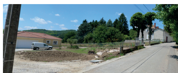
Pavillon en cours de réalisation dans le village
