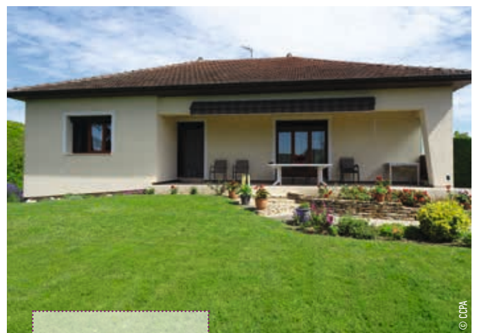
↑ Façade après travaux
