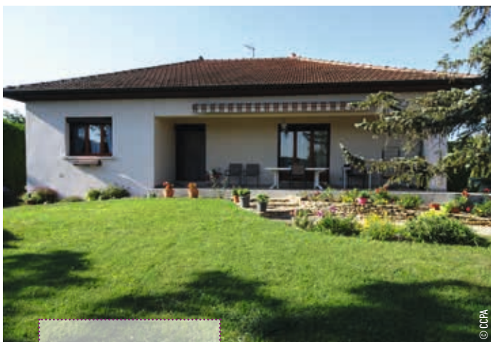
↑ Façade avant travaux
